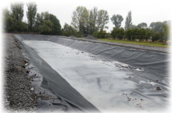
Erdbecken mit Deponiefolie abgedichtet
