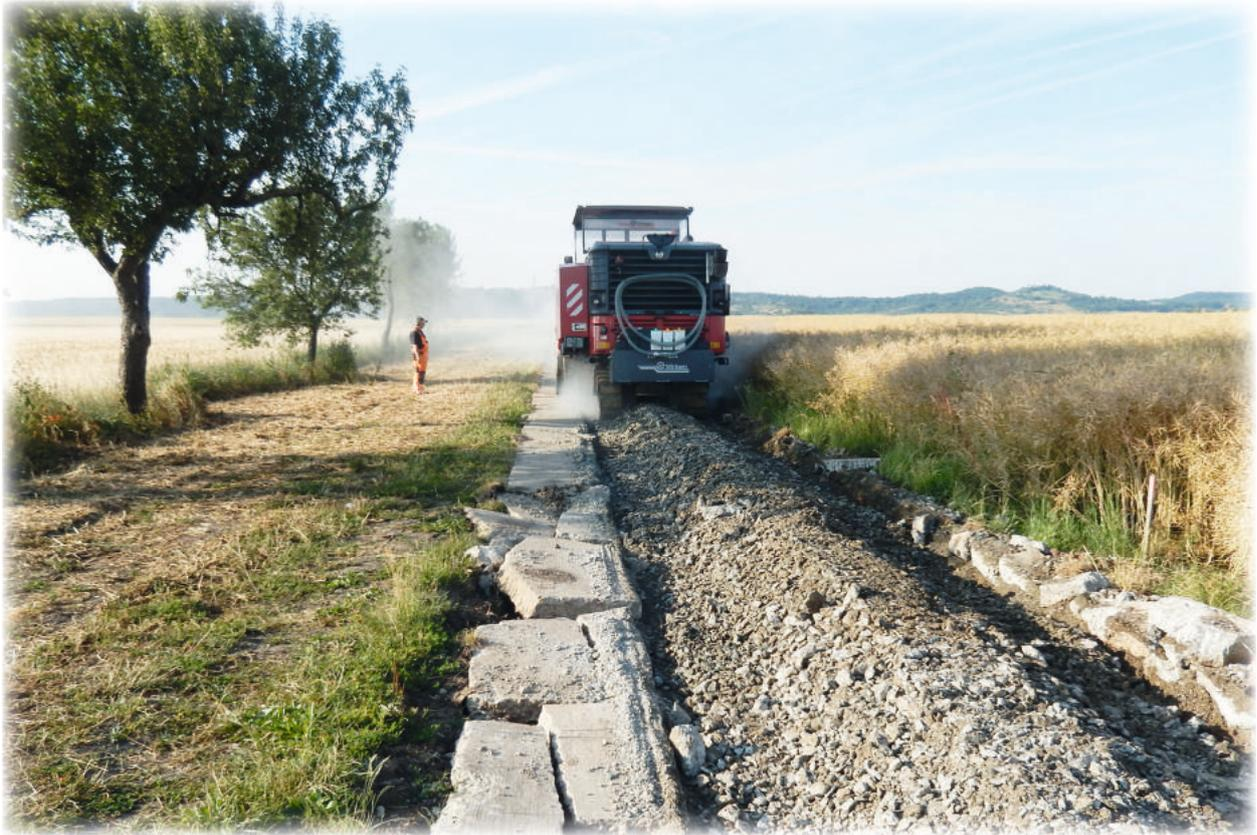
*Bearbeitung des Betonplattenweges nach erfolgter Kampfmittelräumung*
